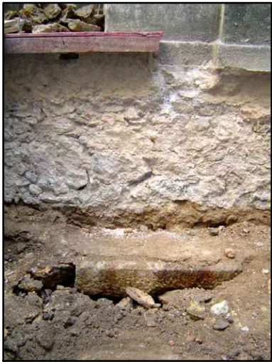
IMAGEM 01: BALDRAME EXISTENTE EM PEDRA ARGAMASSADA
