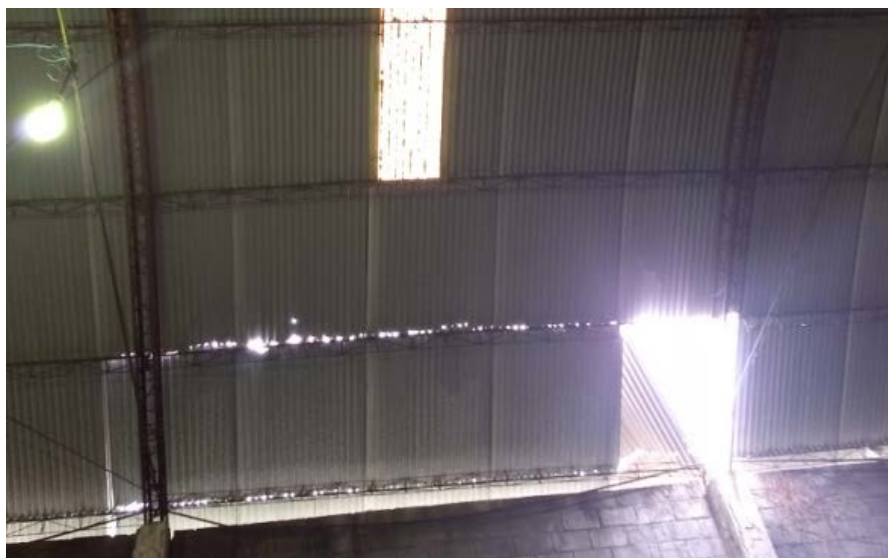
Fotos 01: Telhas quebradas, totalmente danificadas.
