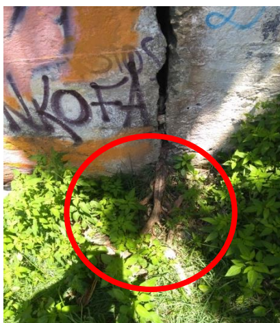
Foto 01: Raiz na base da rachadura do muro externo
