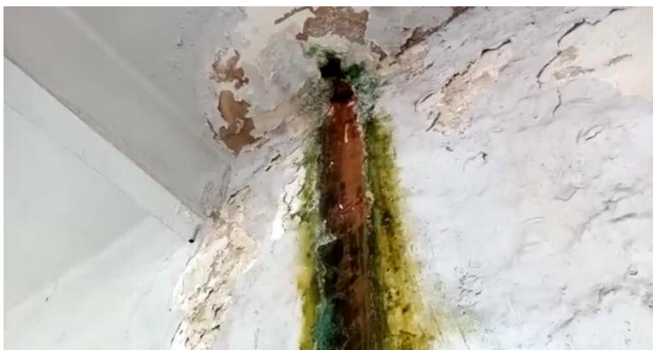
Foto 1 – Tubulação apresentando degradação e vazamento na parede.
