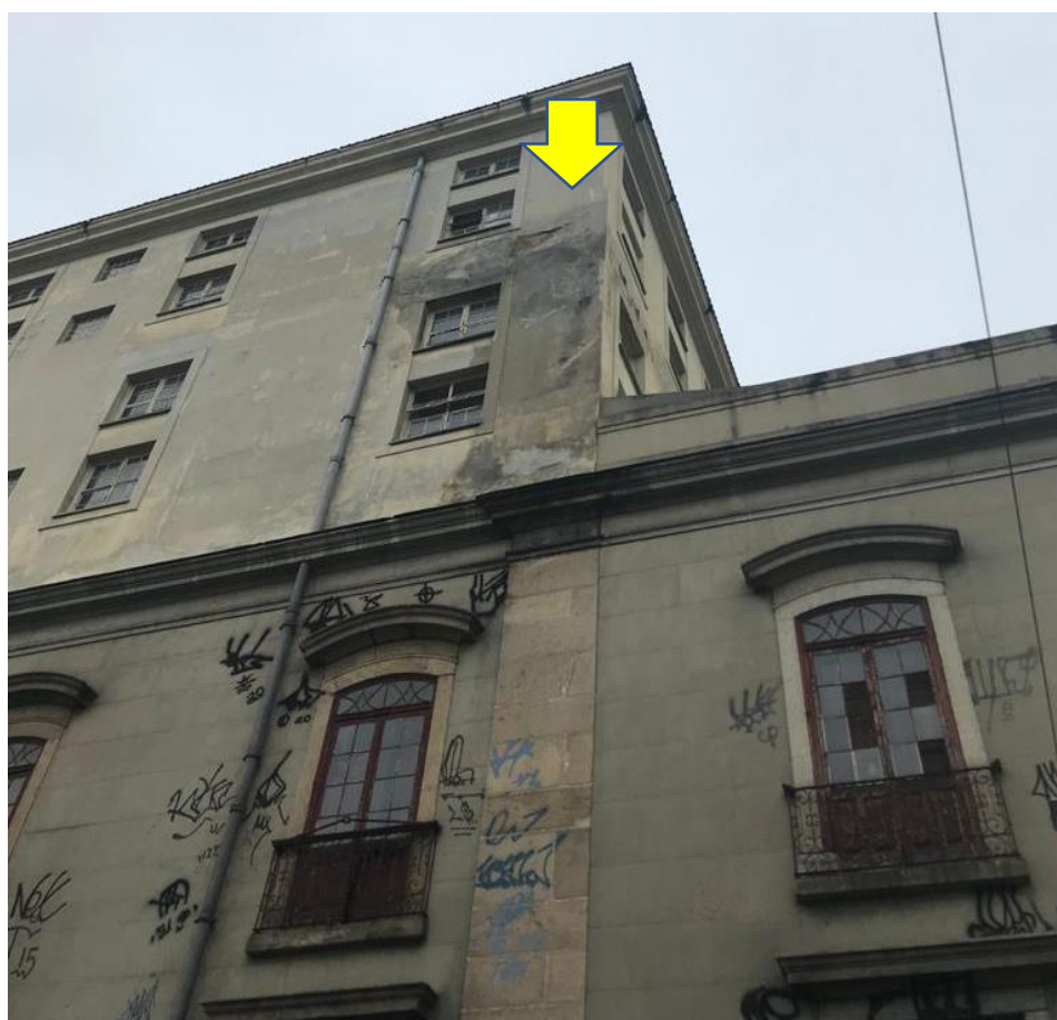
Foto 5 - Vista da fachada, com manchas de vazamento entre as paredes dos banheiros do terceiro e quarto andar.
