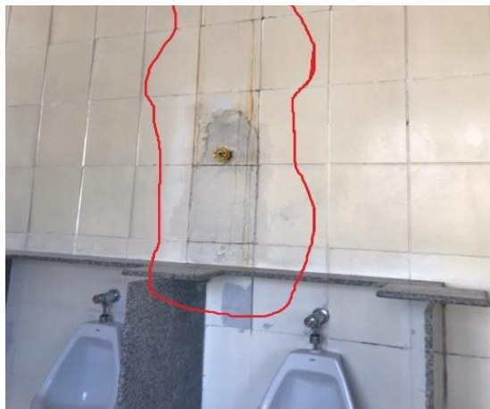
Foto 2 – Reflexos do vazamento na parede, na altura do registro de gaveta.
