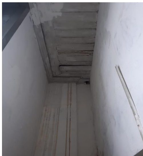
Foto 3 (esquerda) e foto 4 (direita) – Reflexos do vazamento em outros compartimentos nos andares inferiores, degradando pintura.
