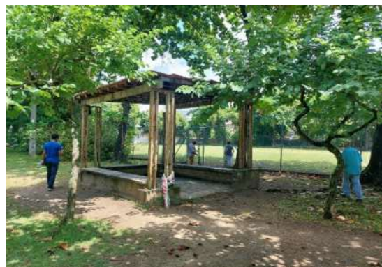
Pergolado de estrutura metálica e base pavimentada de concreto, com cobertura de telhas cerâmicas estruturadas com madeira.
