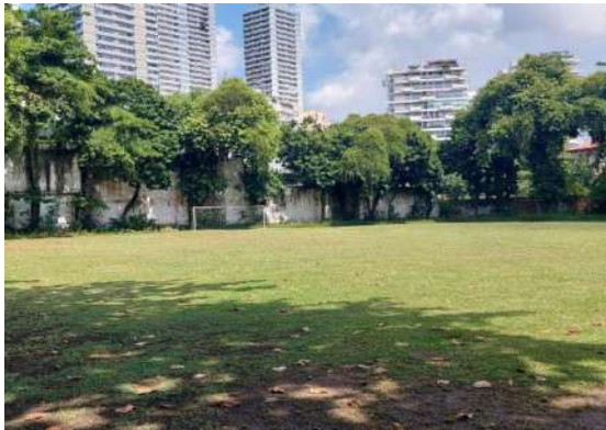
Campo de grama natural, descoberto e composto por 2 balizas e estrutura para fixação de placar e/ou refletores deteriorada.
