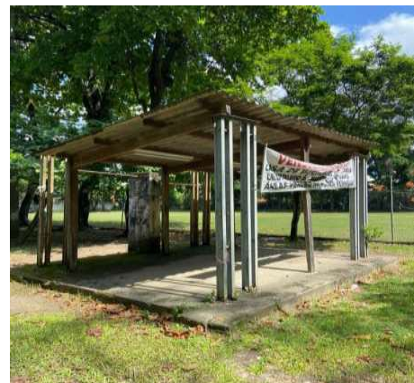
Pergolado de estrutura metálica e base pavimentada de concreto, com cobertura de telhas de fibrocimento estruturadas com madeira.
